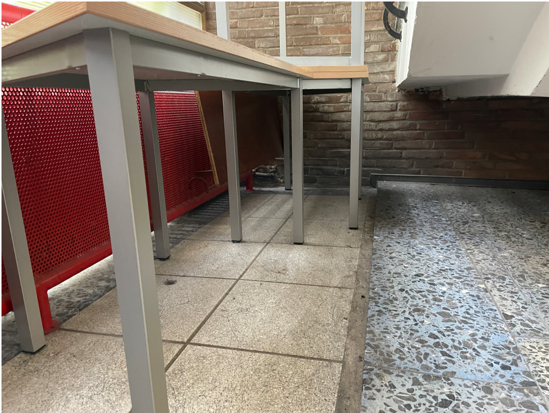
Treppenhaus, Bestandsgebäude GE2
