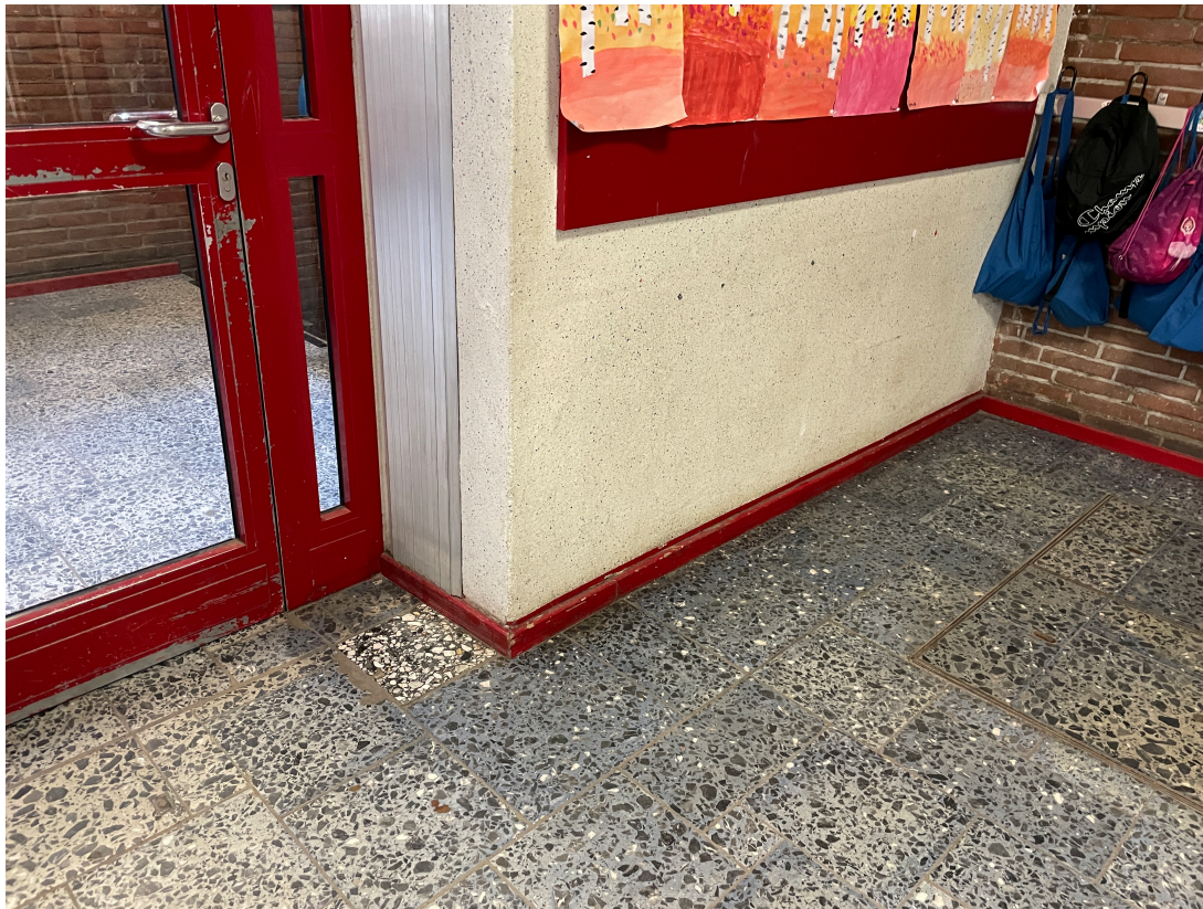
Flur, Bestandsgebäude GE1
