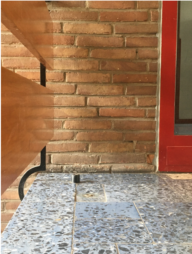
Treppenhaus 2, 1.OG, Bestandgebäude GE1
