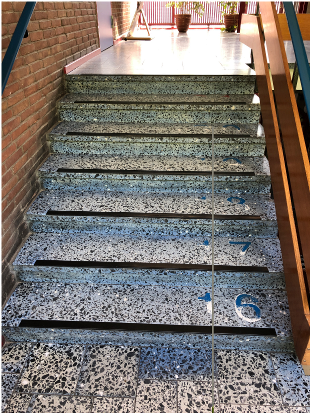
Treppenhaus 1, Bestandsgebäude GE1
