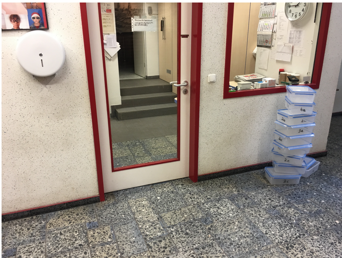
Treppenhaus, Bestandsgebäude GE2
